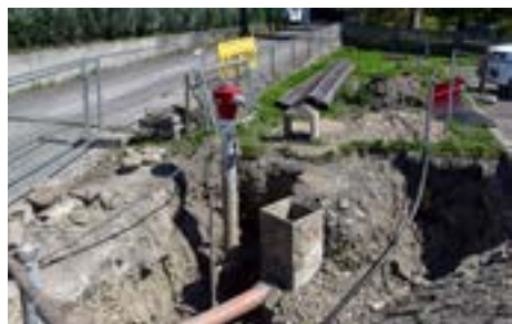
In die Wasser- und Kanalversorgung wurde in Lochau auch 2025 viel investiert.
