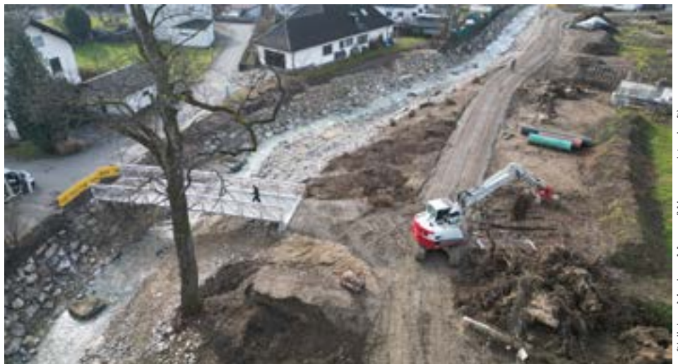
Die Bagger konnten mittlerweile abtransportiert und das Materialdepot zurückgebaut werden.
