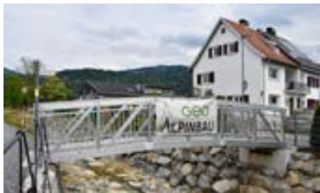
Eine der neuen, breiteren Radwegbrücken über den Ruggbach zwischen Hörbranz und Lochau
