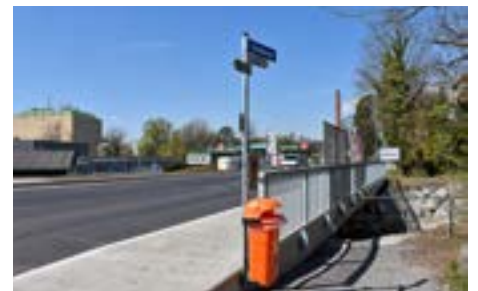
Die neue Straßenbrücke auf der L190 über den Ruggbach verbindet Lochau und Hörbranz. Die Straße wurde Mitte Mai neu asphaltiert.
