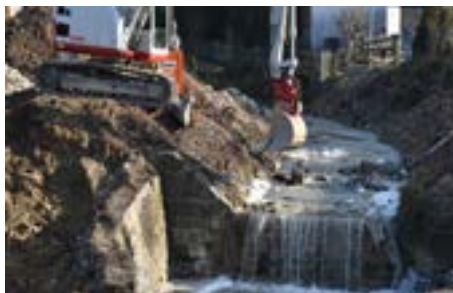
Der Sohlabsturz im Bereich Weidenweg wurde in ein Geschiebeauffangbecken umgebaut.
