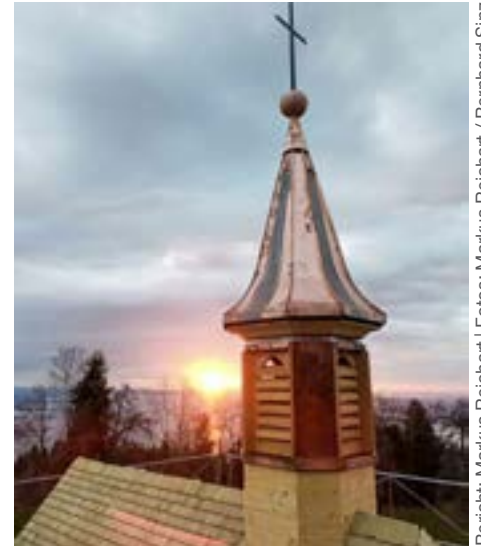
Die Glocke im kupfern eingefassten Turm läutet wieder.
