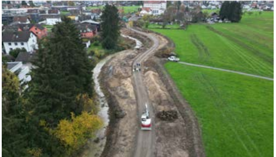
Die Bauarbeiten entlang des Ruggbaches verursachten einen enormen Eingriff in die Natur. Das Hochwasserschutzprojekt ist jetzt abgeschlossen und alles wieder naturnah rückgebaut.
