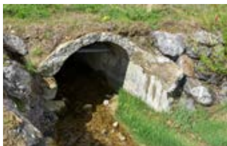
Das alte Rohr beim Kugelbeerbach hat bald ausgedient und wird zurückgebaut.
