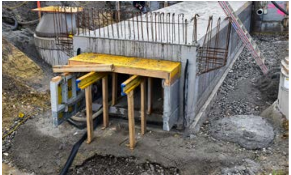
Der neue Durchlass unter der L190 führt den Oberlochauerbach künftig sicher in den Bodensee.
