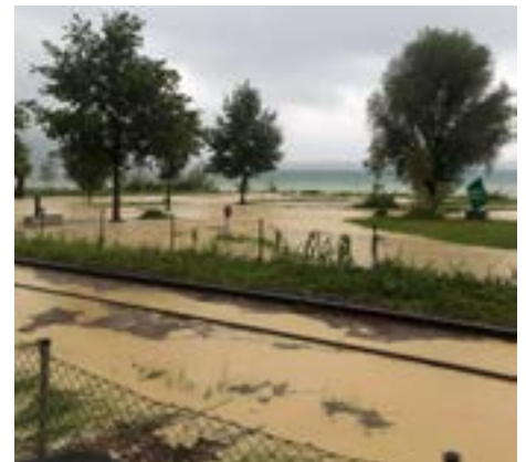
Hochwasser vom August 2022: Die L190 wurde von den Bächen ausgehend überflutet. Der Verkehr auf der Straße sowie auf der Schiene kam zum Erliegen. Solche Bilder sollten nunmehr der Vergangenheit angehören.
