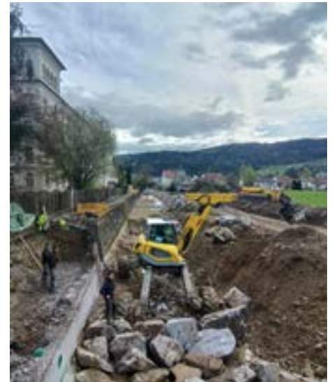
Auch im Bereich des Forums Leiblachtal werden die harten Verbauungen zurückgebaut. Hier entsteht zudem eine sogenannte Fischtreppe.
