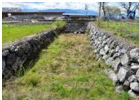
Der Durchlass beim Kugelbeerbach unter der L190 ist auf diesem Bild vom 2. April 2024 noch mit einem Damm gesichert. Nach Abschluss der Arbeiten wird der Bach als offenes Gerinne sicher in den Bodensee geleitet.
