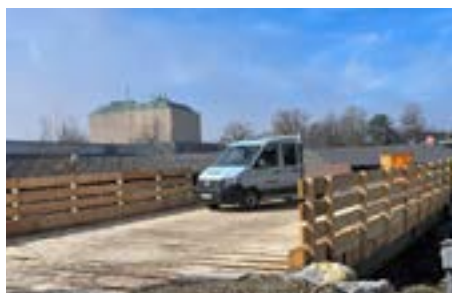
Die Brücke über die L190 wird im Herbst erneuert. Die Behelfsbrücke wurde als Vorleistung für die Weiterführung der Arbeiten im Herbst bereits errichtet.
