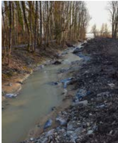
Der Mündungsbereich in den Bodensee bis zur L190 und weiter zur L18 Hörbranzter Straße wurde bereits aufgeweitet und die Sohle ökologisch verbessert sowie neu bepflanzt.
