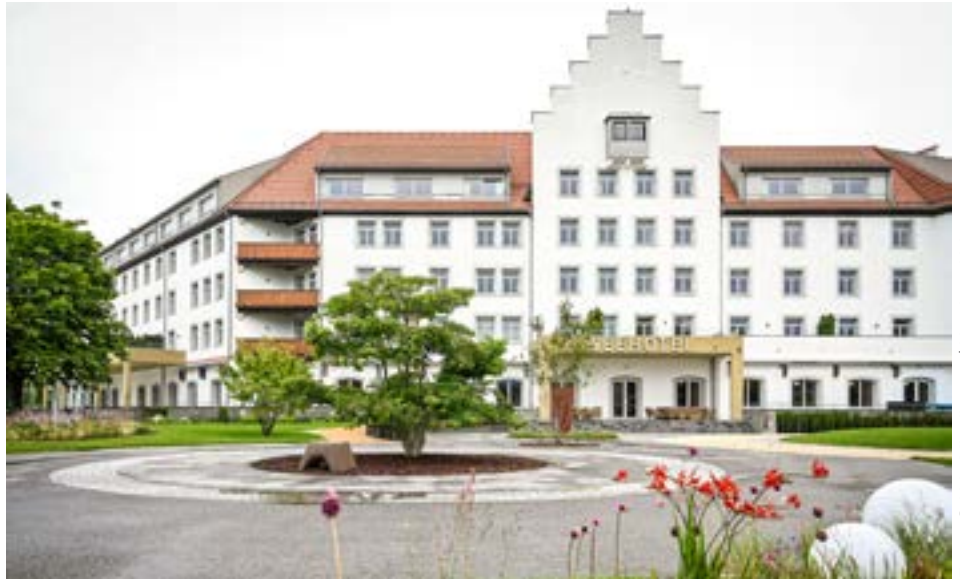
Nach den umfassenden Sanierungsmaßnahmen erstrahlt das Hotel am Kaiserstrand in Lochau wieder in seiner ganzen Pracht.
