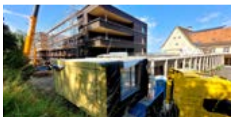
Transport der Fertigzimmer-Holzmodule zum „Haus Pfänder“
