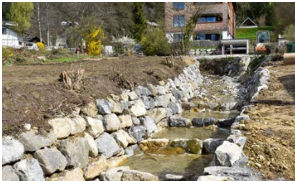
2022 wurde unter anderem der Schwendebach saniert und hochwassersicher gemacht.
