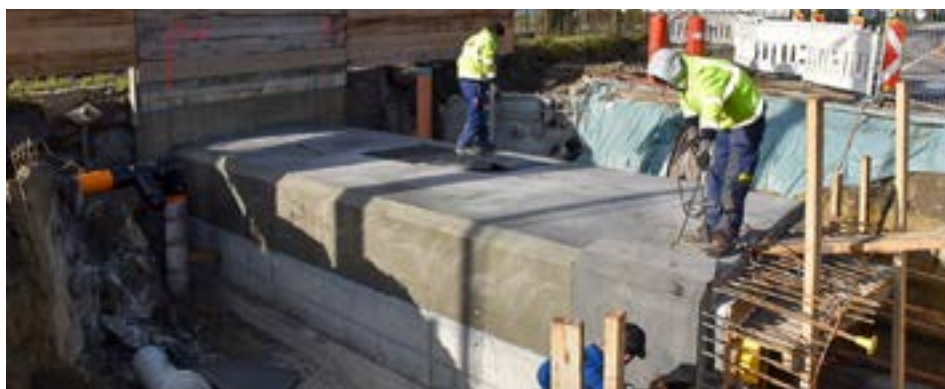
Die neuen Straßendurchlässe unter der Lindauerstraße L190 beim Kugelbeerbach und dem Oberlochauerbach machen die Hochwasserschutzmaßnahmen, die im Jahr 2019 begonnen und etappenweise fertiggestellt wurden, komplett. Die Bäche fließen durch die Kanäle sicher bis zum Bodensee.
