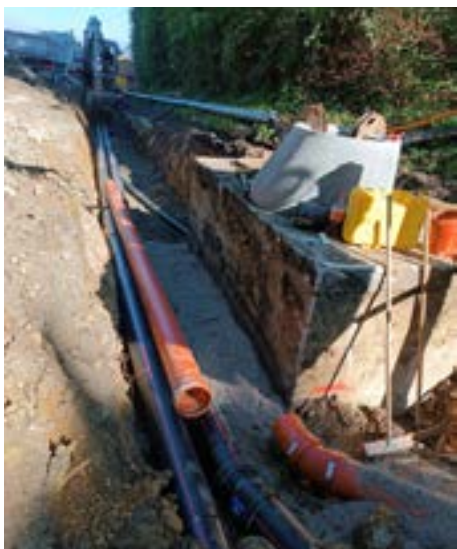
Lichtwellenleitungen komplettieren den Bau der Schmutz- und Niederschlagsleitungen.
