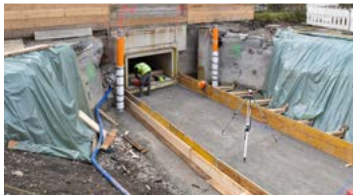
Die neuen Straßendurchlässe unter der Lindauerstraße L190 beim Kugelbeerbach und dem Oberlochauerbach machen die Hochwasserschutzmaßnahmen, die im Jahr 2019 begonnen und etappenweise fertiggestellt wurden, komplett. Die Bäche fließen durch die Kanäle sicher bis zum Bodensee.
