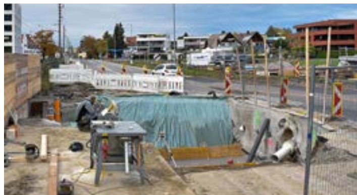
Die neuen Straßendurchlässe unter der Lindauerstraße L190 beim Kugelbeerbach und dem Oberlochauerbach machen die Hochwasserschutzmaßnahmen, die im Jahr 2019 begonnen und etappenweise fertiggestellt wurden, komplett. Die Bäche fließen durch die Kanäle sicher bis zum Bodensee.
