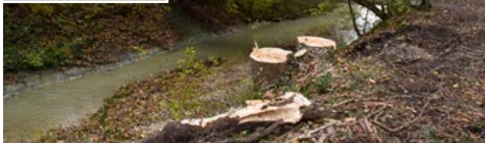
Am Ruggbach wurde Anfang November der Wald auf Hörbranzer Seite gerodet. Fertigstellung des Gesamtprojekts ist für Herbst 2024 geplant.
