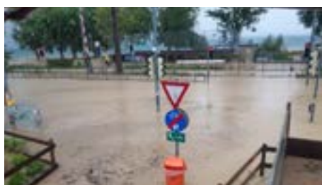
Beim Hochwasser 2022 wurden die Folgen der zu schmalen Durchlässe zuletzt sichtbar.
