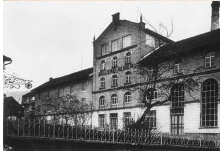
Brauerei Reiner Abbruch 1982
