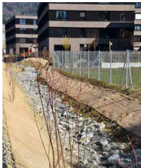
Hochwasserschutzmaßnahmen im Einklang mit einer Renaturierung des Kugelbeerbaches beim neuen Seedomizil
