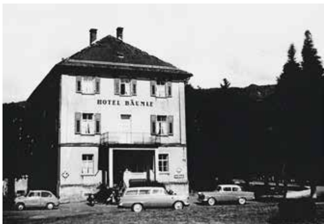
Hotel Bäumle Abbruch 1987/88
