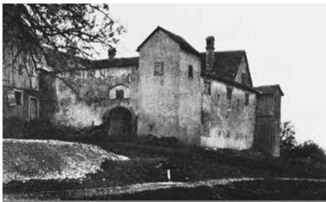
Nordportal des ehemaligen Edelsitz Oberlochau mit Wehrturm
