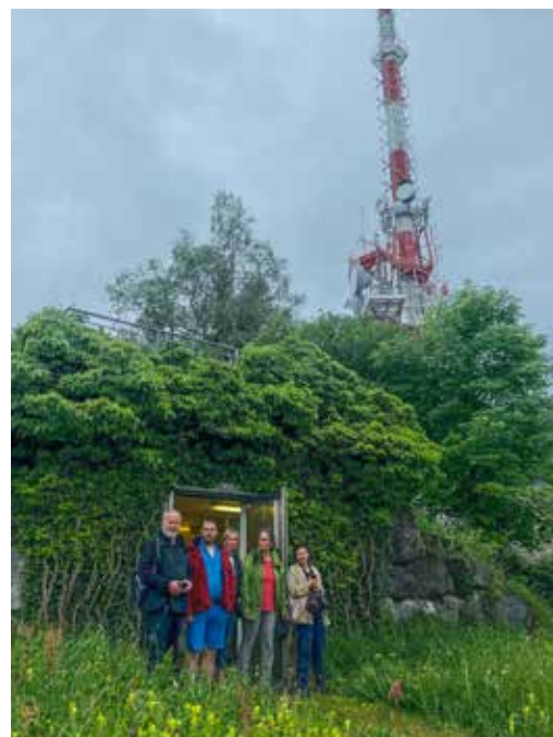
Das Trinkwasser wird über das Pumpwerk Klause auf den Pfänder gepumpt. Die Teilnehmer*innen der Wasserwanderung marschierten zu Fuß entlang der diversen Stationen auf den Pfänder.
