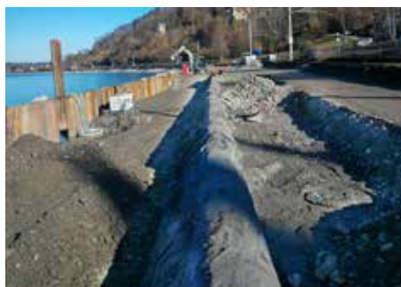
Die im Jahr 1997 als Ölleitung stillgelegte und während der Bauarbeiten vorübergehend freigelegte Pipeline.
