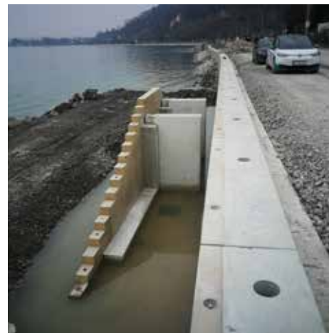
Der neue Treppenabgang - in paralleler Ausrichtung zum ÖBB-Gleis
