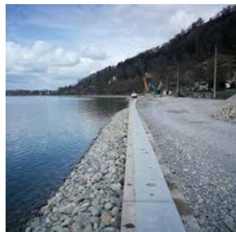
Durch die Aufschüttung wurde ausreichend Platz für den Rad- und den Fußgängerweg geschaffen.
