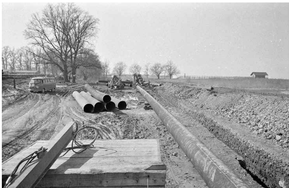
Bau der Pipeline am Bodenseeuf (1965)
