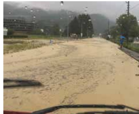
Die Landesstraße L190 stand über weite Teile komplett unter Wasser.
