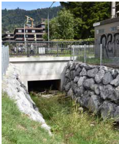
Die von der Gemeinde Lochau im Zuge des Ausbaus der Hochwasserschutzmaßnahmen errichtete Brücke beim Oberlochauerbach steht bereit. Jetzt ist das Land Vorarlberg am Zug. Wenn alle Bäche hochwassersicher gemacht sind, sollten Überschwemmungen in diesem Bereich der Vergangenheit angehören.
