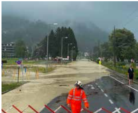
L190: Hier fehlen noch die seitens des Landes zu errichtenden Brücken; der dann größere Durchlass verhindert ein Übertreten der Bäche.
