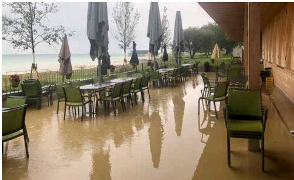
Obwohl die Terrasse im Strandbad Lochau überflutet wurde, blieb das Gebäude vor Schäden verschont.
