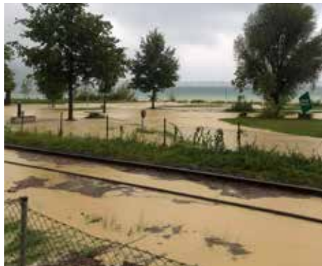
Die Bahnstrecke musste eine Zeitlang komplett gesperrt werden.
