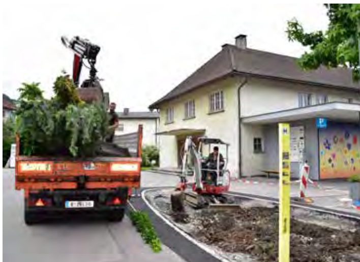
Der Untergrund wurde ausgehoben und durch Baumsbstrat ersetzt
