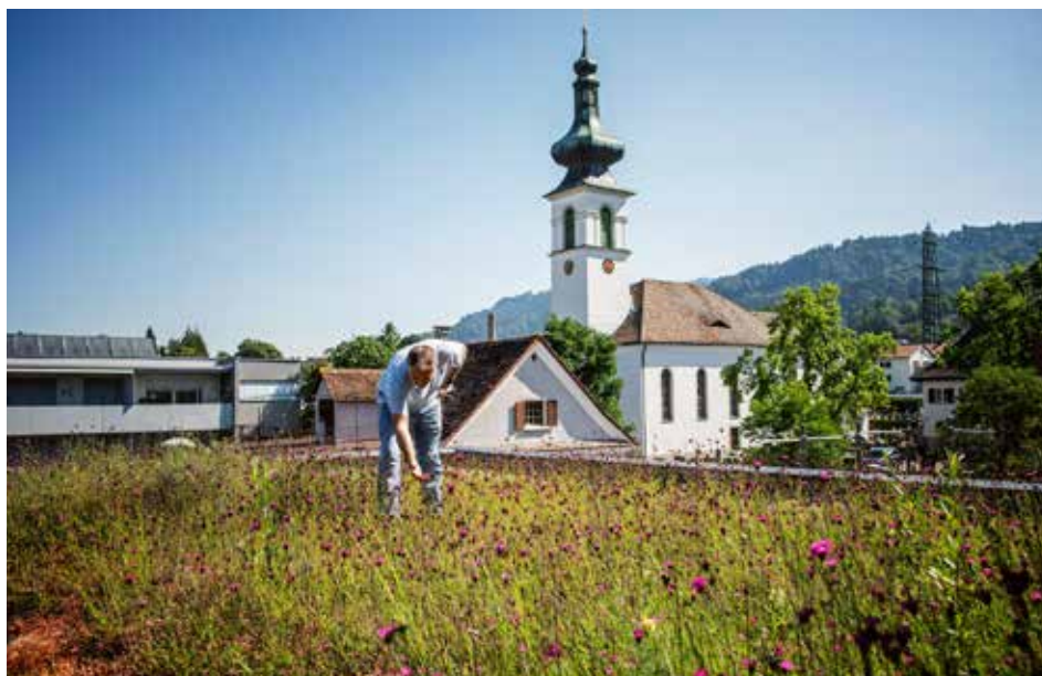
Begrüntes Dach: Das Gemeindeamt Lochau geht mit gutem Beispiel voran
