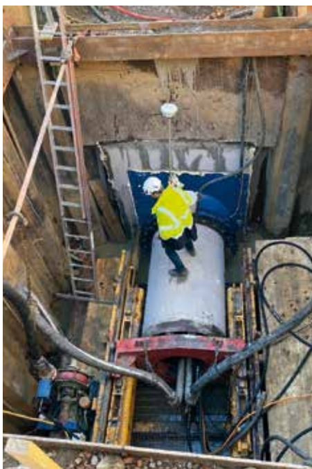
Die Errichtung der neuen Verrohrungsstrecke für den Wellenaugraben erfolgte im Microtunneling-Verfahren
