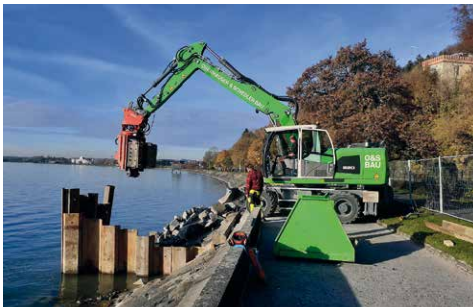
Neue Verrohrungsstrecke im Bereich der Landesstraße L190, ÖBB-Bahntrasse und Pipeline
