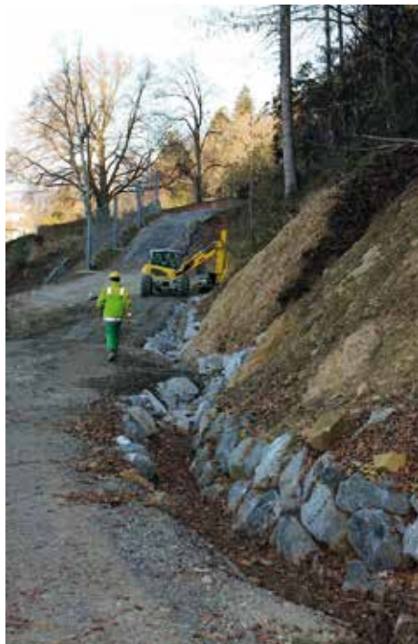
Bergseitige Entwässerungsgräben und „der neue Wellenaugraben“ wurden errichtet
